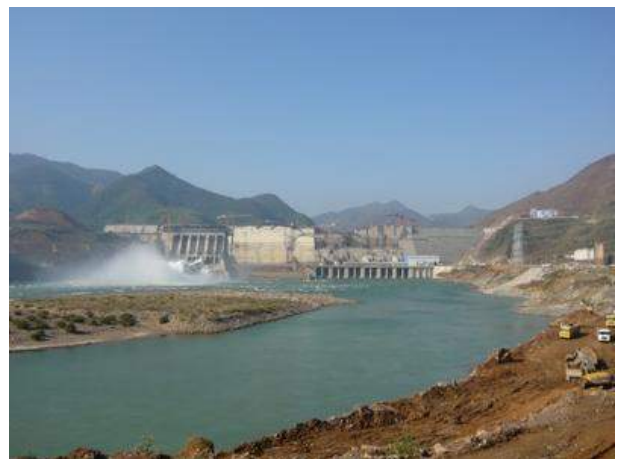
Nhà máy Thủy điện Sơn La
